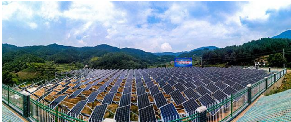
安徽省金寨县金刚台村200kW跟踪式村级光伏扶贫电站。
